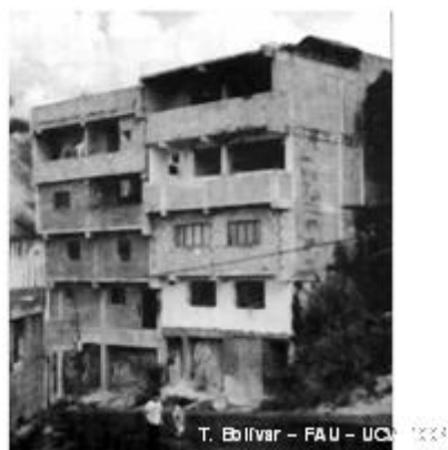
Foto 5. Implicaciones de Viviendas Progresivas en la Respuesta Estructural.
