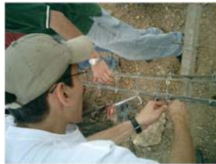
Foto 10. Construcción del 2do. Módulo- Semilla de vivienda, utilizando adobe y carrizo (bambú).
