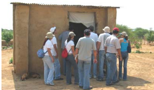
Foto 9. Construcción de un módulo-semilla de vivienda. El Oasis marzo 2004
